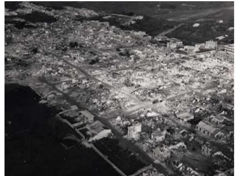
1968 Terremoto del Belice
